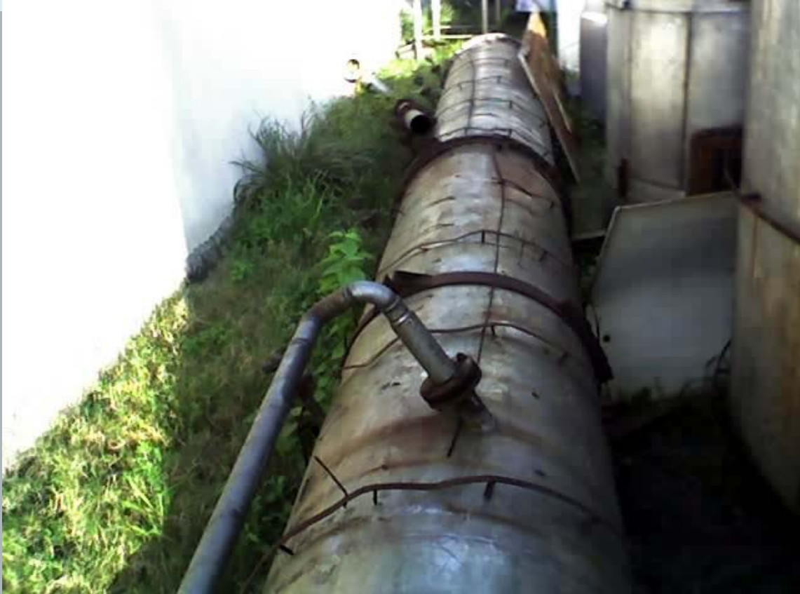
IMG 37 e 38 Coluna de Destilação de Álcool
